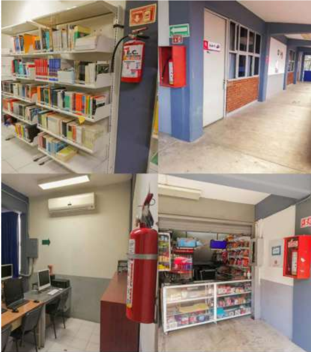
"Cambio y mantenimiento de extintores"
